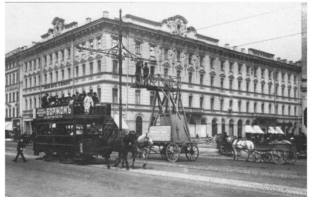
Илл. 14. Укрепление электропроводов для трамвайного движения на Невском проспекте. фотография, К. Булла, 1907
